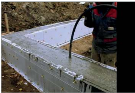
Виброуплотнение бетона с помощью глубинного вибратора.
