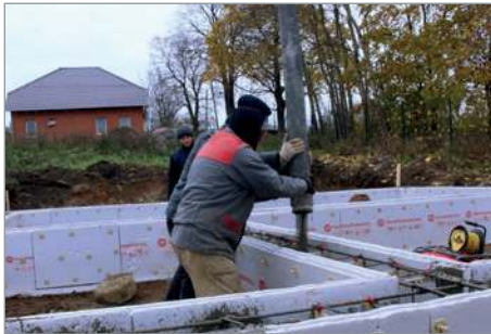
Подача бетона в опалубку при помощи бетононасоса.
