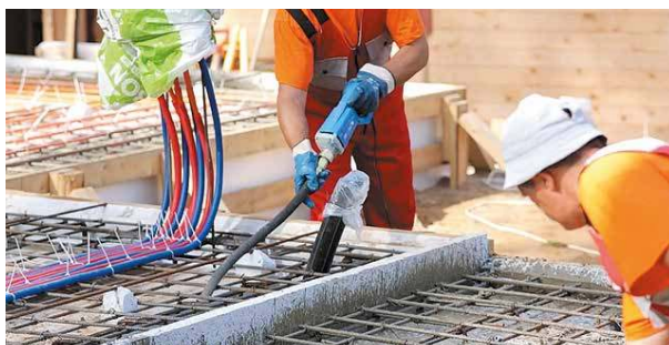
Вибрация бетонной смеси в ребрах жесткости.
