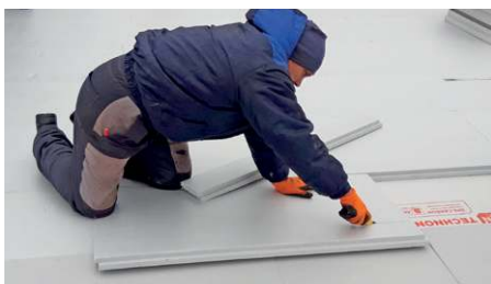
Пример формирования основного уклона и контруклона между водоприемными воронками.
