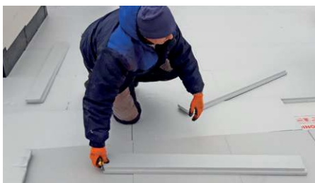
Пример формирования основного уклона и контруклона между водоприемными воронками.
