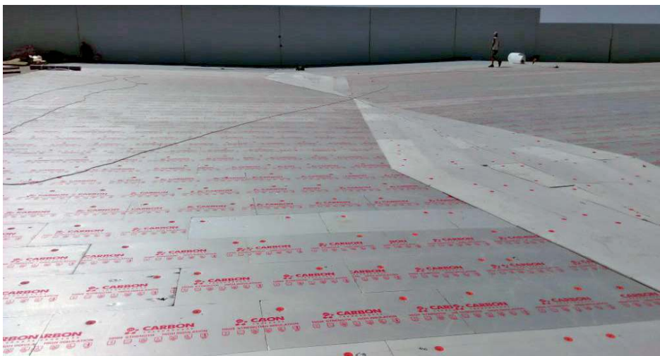
Пример формирования основного уклона и контруклона между водоприемными воронками.
